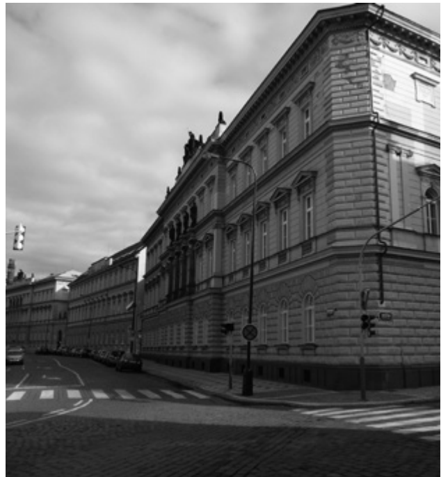
Budova Ministerstva spravedlnosti ČR ve Vítězské ul. v Praze (rohová budova je přímo s MS sousedící gymnázium Botičská)
